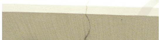
バルコニー手すりに発生した乾燥収縮ひび割れ
